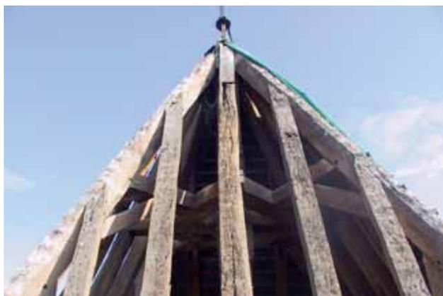
Octobre 2007 : les travaux de maçonnerie du clocher débutent avec le montage des échafaudages. L'ancien ravalement est piqueté sur 13 centimètres d'épaisseur, soit plus de 80 mètres cubes de gravats, 12 camions seront nécessaires pour les évacuer.
