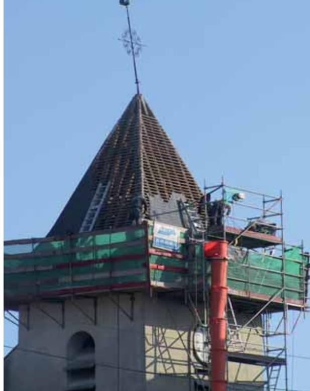
Une remise aux normes de l'électricité du clocher et de la sacristie a été réalisée ainsi que la couverture des abat-sons et des têtes de contreforts.
